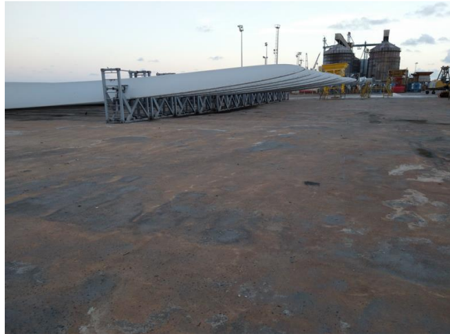
Figura 4 – Local de instalação dos silos.
