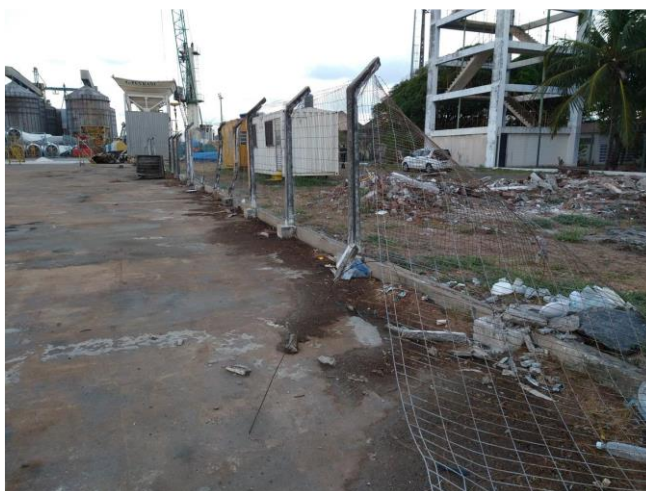
Figura 1 – Alambrado na área REC08.
